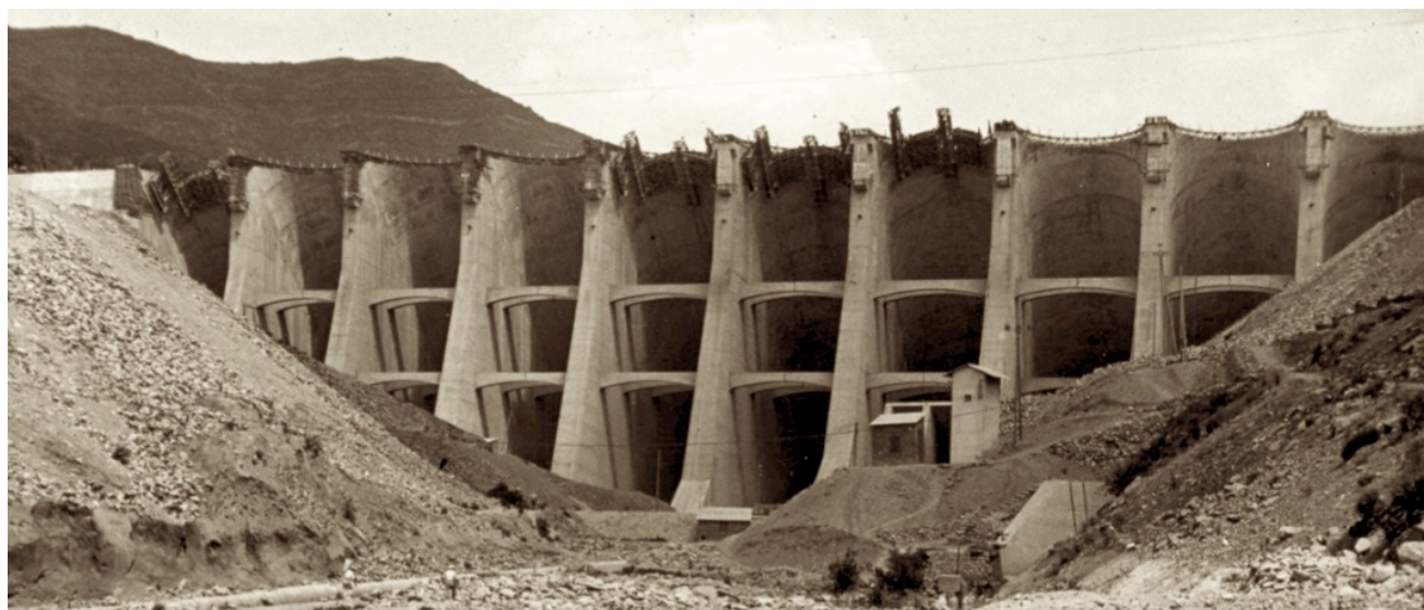
Achèvement du barrage des Beni Bahdel vu de l'aval (65 m au-dessus du lit de l'oued)
